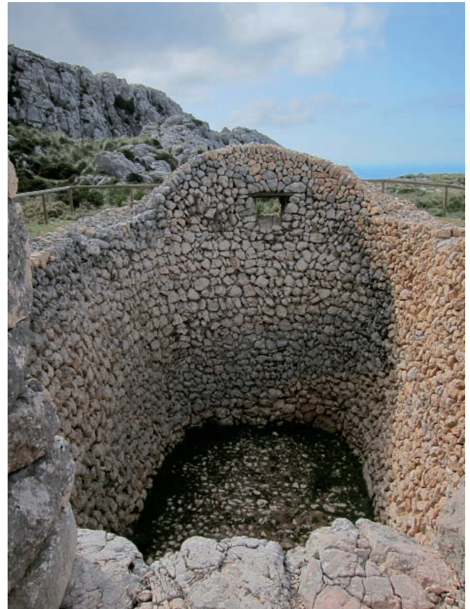
Pou de glaç reconstruït
