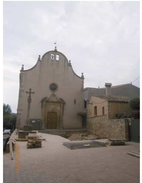
Vista general de l'excavació, amb l'església del Portal
