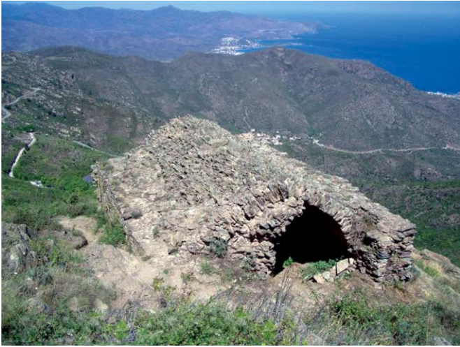
Cisterna exterior amb la seva volta apuntada.
