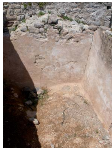
Detall de la cisterna amb les parets impermeabilitzades.
