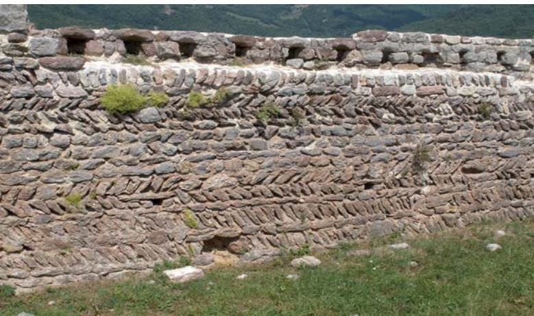
Detall del mur, amb aparell d'opus spicatum, a la gran sala del recinte jussà.
