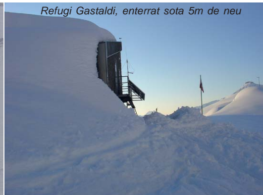
Refugi Gastaldi, enterrat sota 5m de neu
