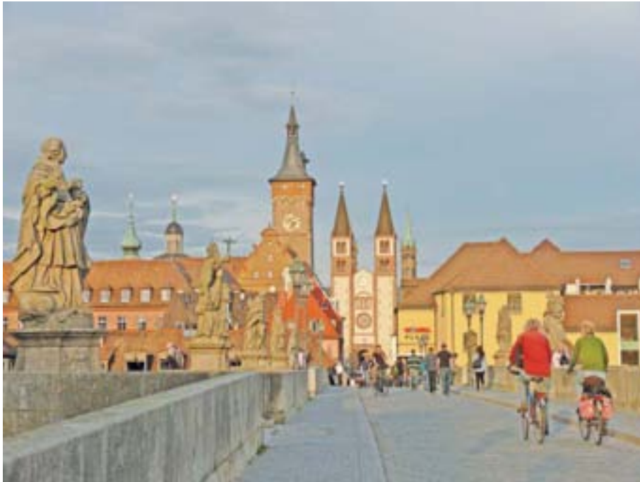
El pont sobre el riu Meno a Würzburg
