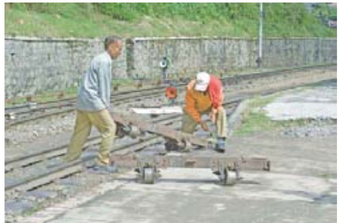
Treballs a la via
