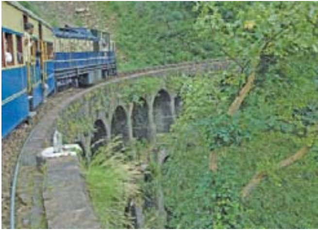
Passant un viaducte
